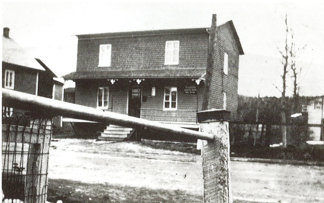
Bureau de poste en 1938
