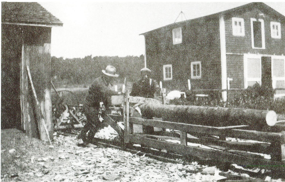
Pièce de bois de 10' de long et d'au moins 6'' de diamètre, placée sur un chariot tiré à bras d'homme; la mèche était tournée par un engin à gazoline.
