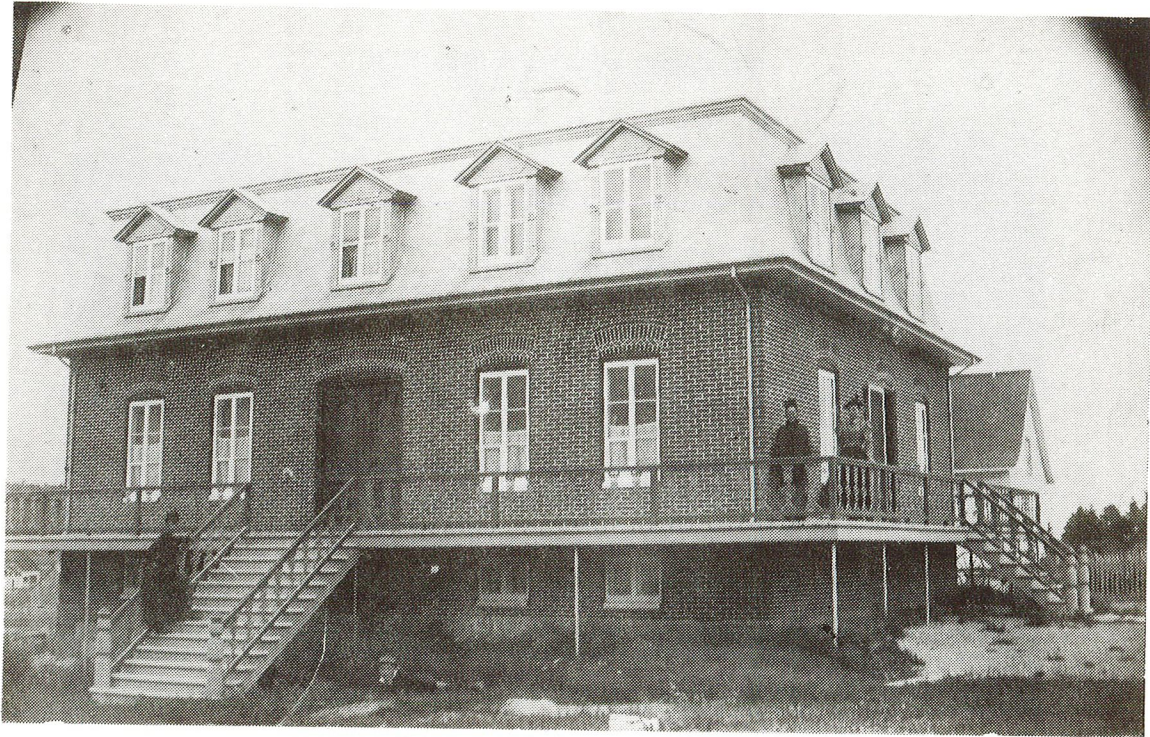
Presbytère vers 1900 (Construit en 1892)
